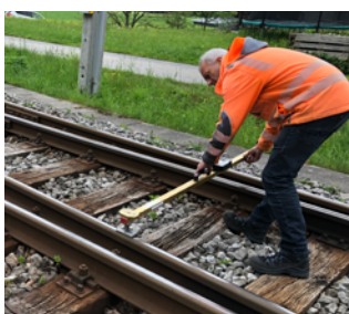
Vermessung einer Weichenprüfung
